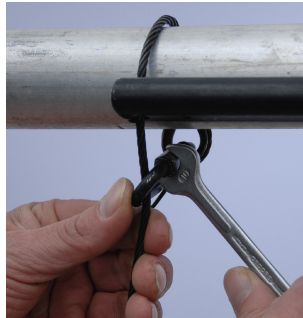
Bild 6: Schnellverbindungsglieder mit einem Maulschlüssel vollständig schließen.
